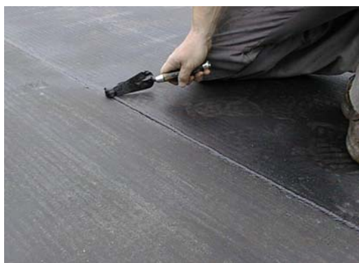
Recuperatie van de overtollige mastiek met truweel
