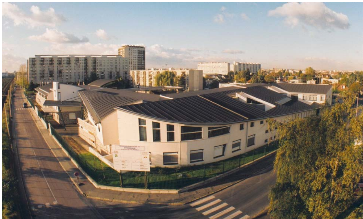
DERBICOLOR waterdichting met DERBILIST elementen op het dak van een school in Frankrijk.
